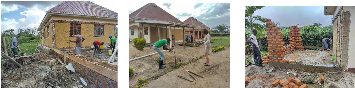
Bau des Hinterhofes, eines Geräteraums und Umgebungsarbeiten unter Anleitung von Kartin.
